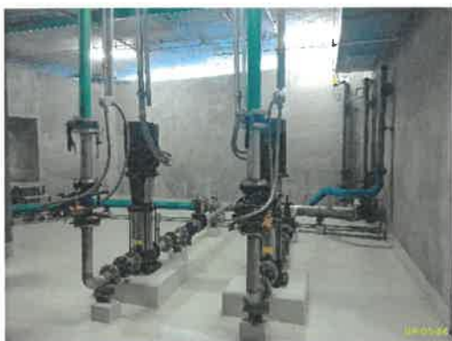
ปั๊ม และถังสำรองเพื่อการอุปโภค-บริโภค ภาพที่ 1.3.4-1 ระบบน้ำใช้
